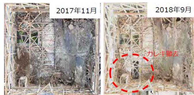
1号機建屋上部のガレキ撤去の進捗状況
