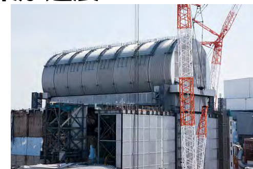
3号機原子炉建屋ドーム屋根
