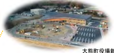
大熊町役場新庁舎(建設中)
