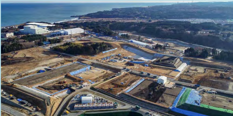
中間貯蔵施設(大熊②工区周辺)
