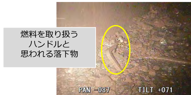
2号機内部調査で撮影【2018年1月19日】
