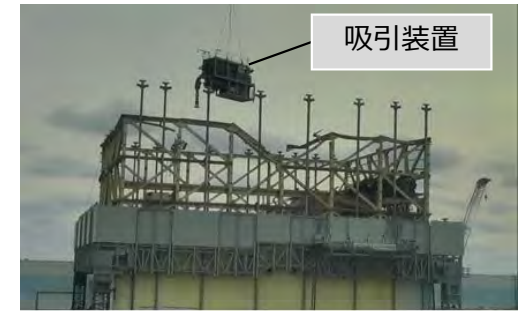
ガレキ撤去の作業状況（2018年1月22日）
