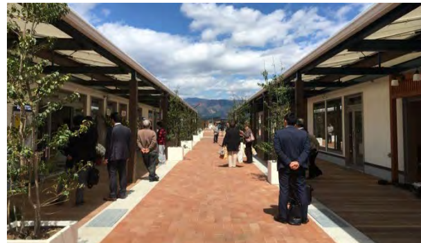
テナント型商業施設(岩手県大船渡市)
