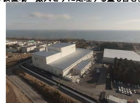
大熊町の仮設焼却施設
