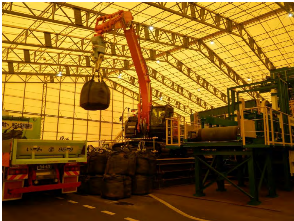
受入・分別施設(1期双葉工区) (処理能力 140t/h)
