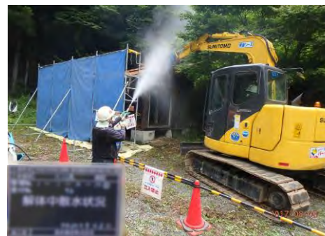
被災家屋等の解体の様子
