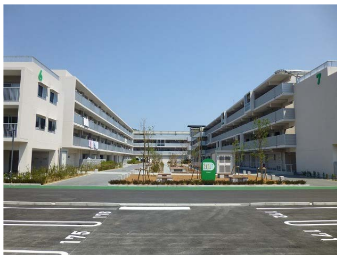
災害公営住宅（宮城県女川町）
