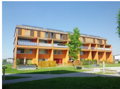
CLTを用いた集合住宅(ウィーン)
