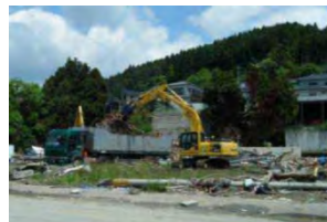
【被災家屋の解体・撤去】
