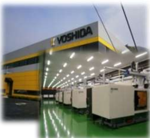
▲移転建設された新工場 (岩手県大船渡市)
