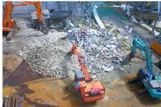
4号機周り支障物解体
