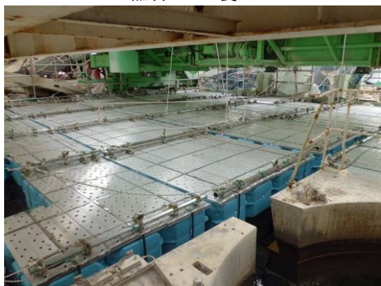
燃料プール養生
