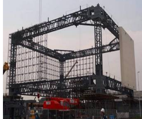
小名浜港における仮組状況(8/10時点)
