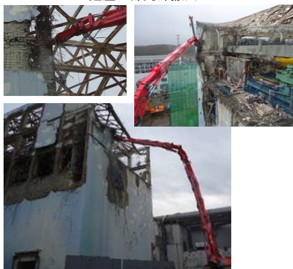
建屋上部瓦礫撤去
