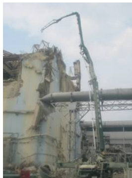
コンクリートポンプ車を使用してのサンプリング
