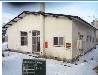
▶ 解体された本町生活館 (解体前)
