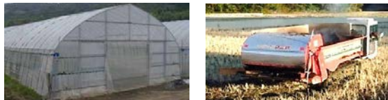
継承するハウスの改修
